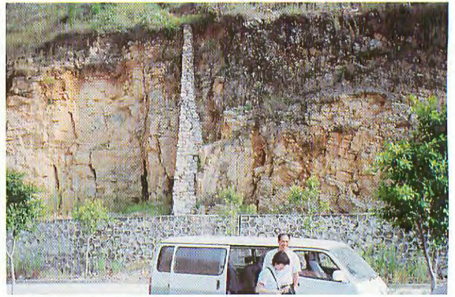
写真一10 奉節市街地斜面上部の地すべり移動ブロック. 開口亀裂を石積で充填. その左右で構造が不連続
