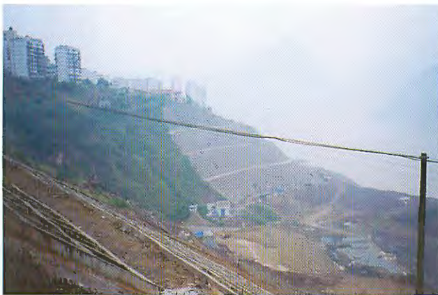
写真一13 巫山市街. 擁壁工が施された地すべり崩積土を基礎地盤とする高層アパート群.
