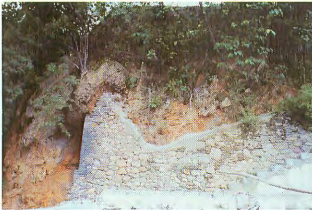
写真一11 奉節県白帝城の基礎地盤. 標高145m付近の地すべり移動・破壊物質と擁壁工.
