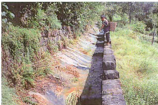
写真-3 宝塔地すべり斜面上部の地表面排水溝。
