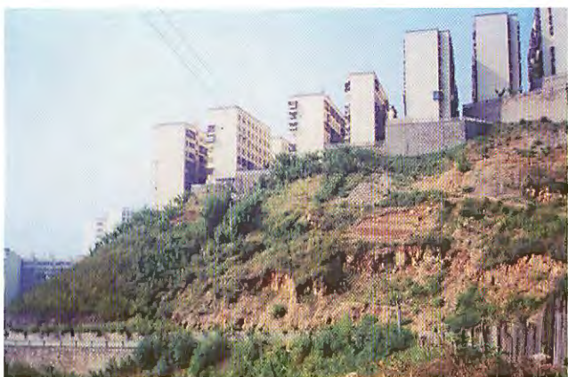
写真-5 奉節市街、高層アパートが林立、その基礎地盤は地すべり崩積土。
