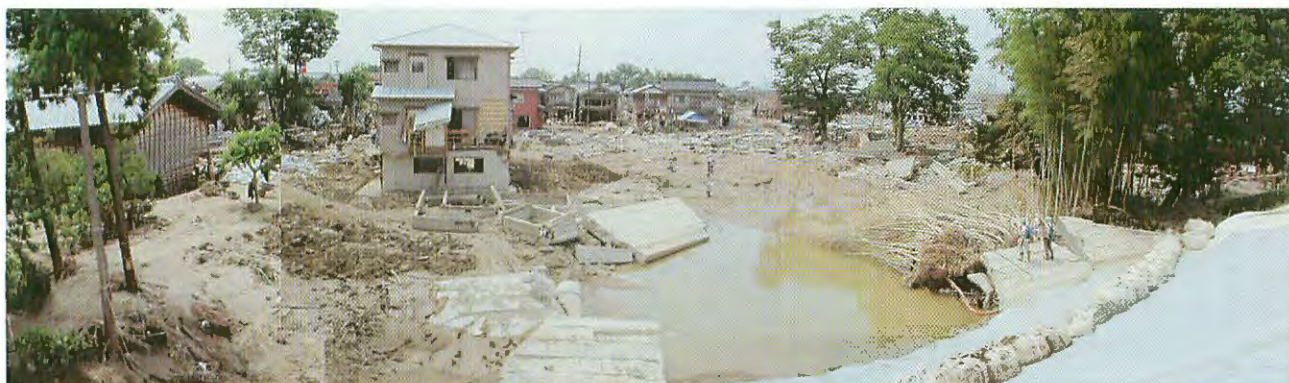
写真-3 破堤箇所の全景 破堤箇所の堤内側には洗掘により落堀が形成され、その上には堤内側の擁壁が飛ばされている。落堀には妙栄寺が位置していたが跡形もなく破壊され、その基礎が回転して裏向きとなって残存している。7月24日撮影。
