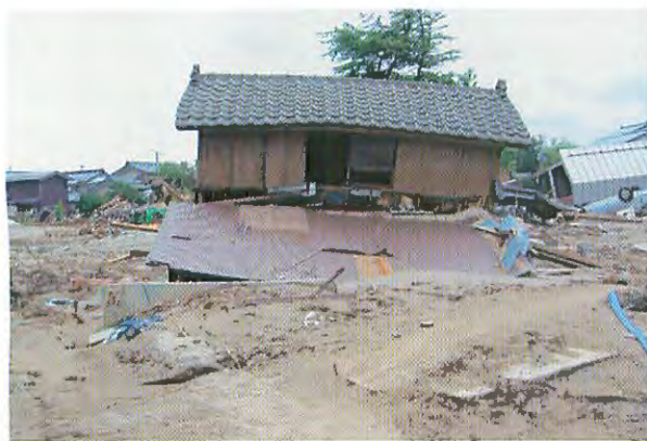
写真-4 洪水流により移動し1階部が破壊した家屋 周辺には土砂が厚く堆積している。7月24日撮影。
