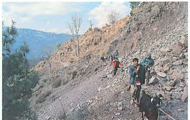
写真-8 チッカール村からハッティアン地すべりに向かう林道沿いの崩壊
