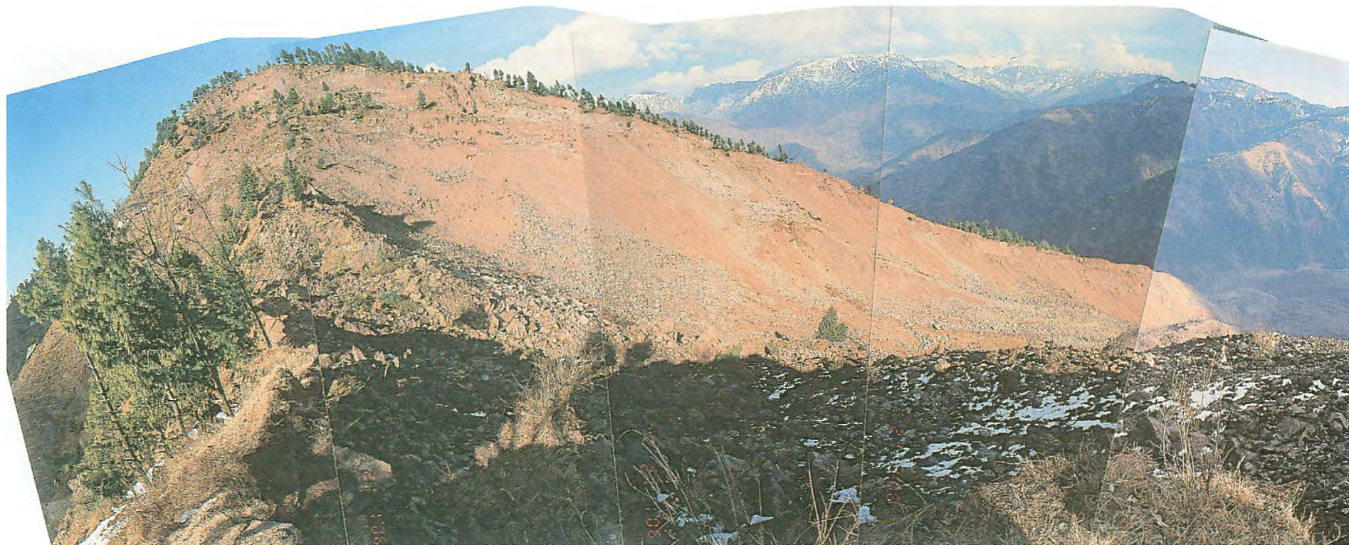
写真-11 ハッティアン地すべり上流側の側壁から、地すべり地内を臨む。 (上部側壁から隣接斜面に掛けて多数のクラック及び段差が見られる。)
