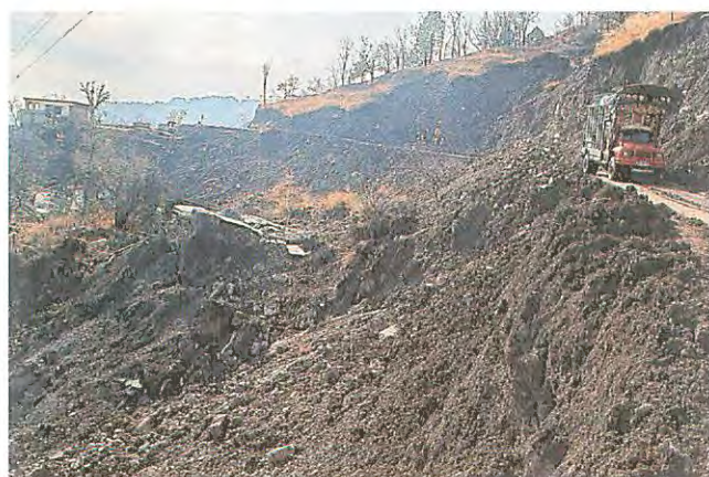
写真1 地すべりによる道路崩落箇所
