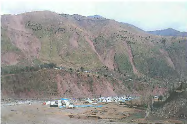
写真-5 ジェラム川右岸で連続する崩壊斜面 避難用テント多数が河床に設置されている。 (拡大崩壊が発生した場合、崩落土砂の到達範囲内 に設置されており危険である。)
