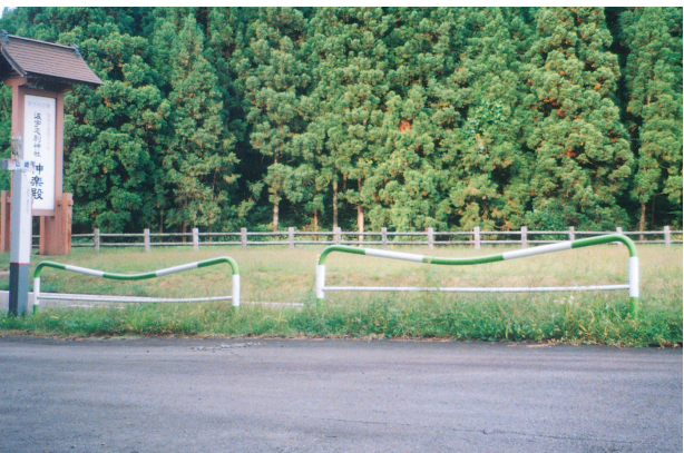
写真－９ 雪の沈降力により湾曲したガードレール (横手市大森町)
