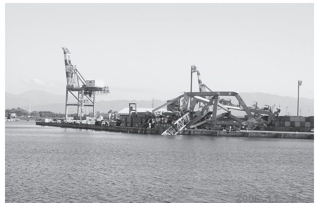
写真-2 倒壊したクレーン（全景）
