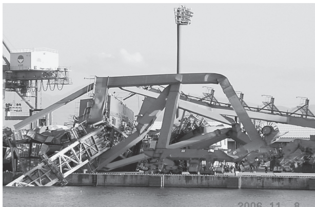
写真-1 倒壊したクレーン
