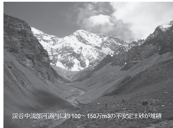
図4 渓谷中流部山腹斜面及び河道の状況
