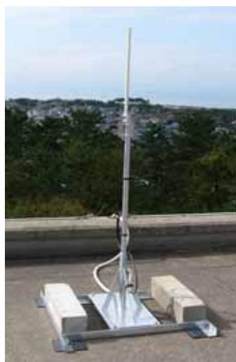
図 3 . 据置設置
