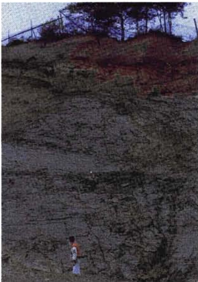
(3) 竹野町層 (泥岩層) と仁箇層 (砂層) の不整合 (城山運動公園北方).
