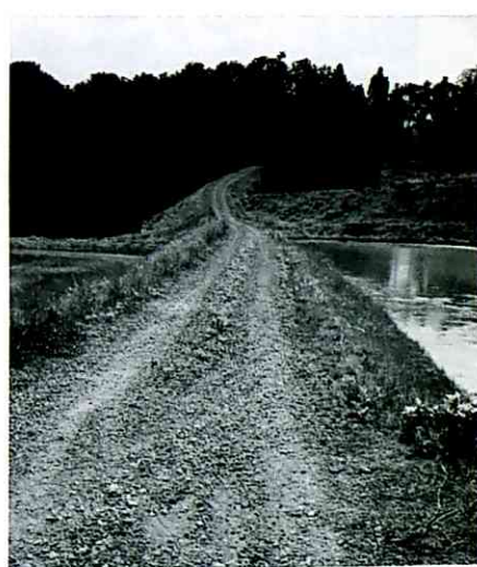
写真－9 導流堤と復旧された県道（砂利道）
