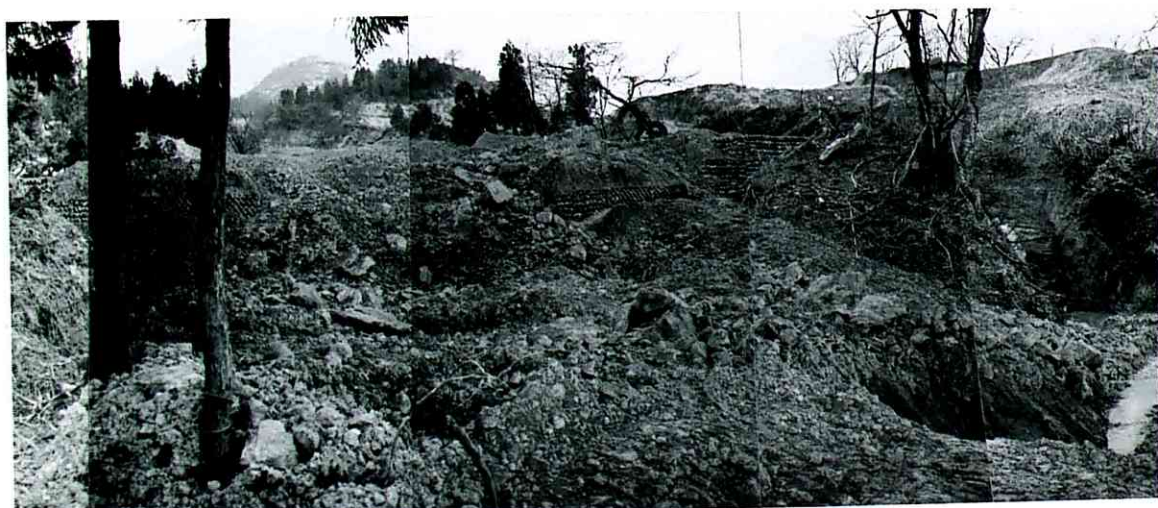
写真－7 施工中の堰堤を乗り越えた土砂 泥岩の角礫が多い。下流400 m付近
