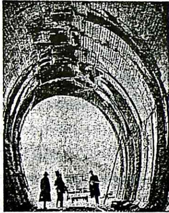
A. 崩壊前の変状 (28.12. 4)
