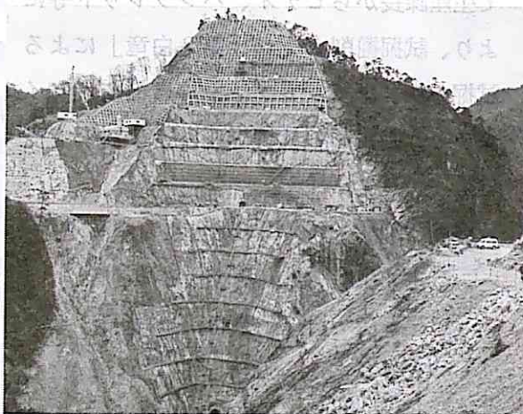
ダムサイト左岩の岩盤状況
