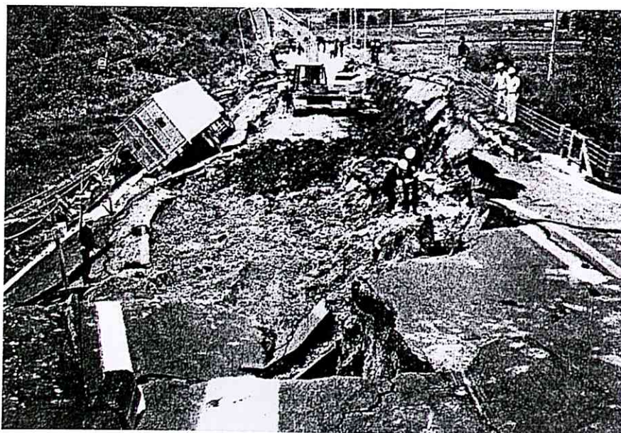
写真-5 道路盛土の崩壊（国道5号線長万部町蕨岱～二葉間）
