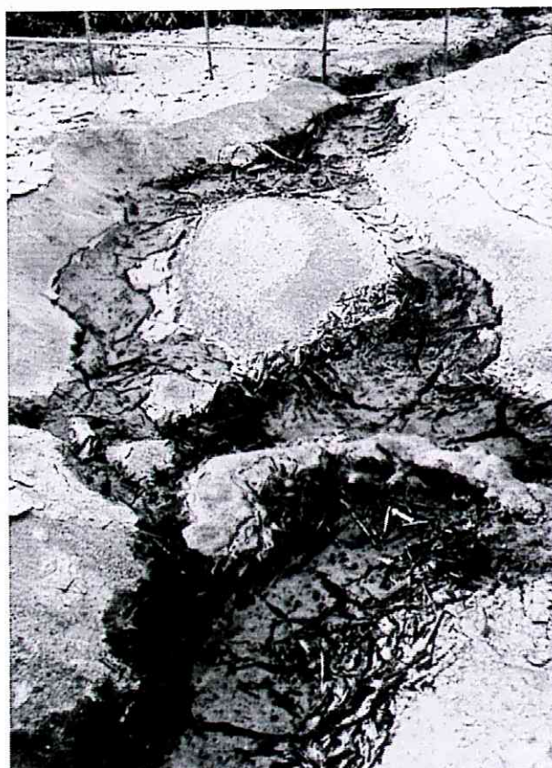
写真-8 今金町豊田、ビニールハウス内の噴砂
