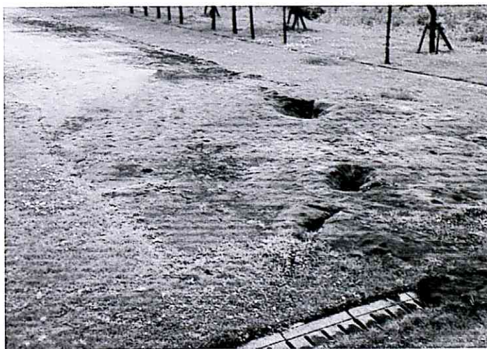
写真-5 グラウンドの噴砂と噴砂孔列
