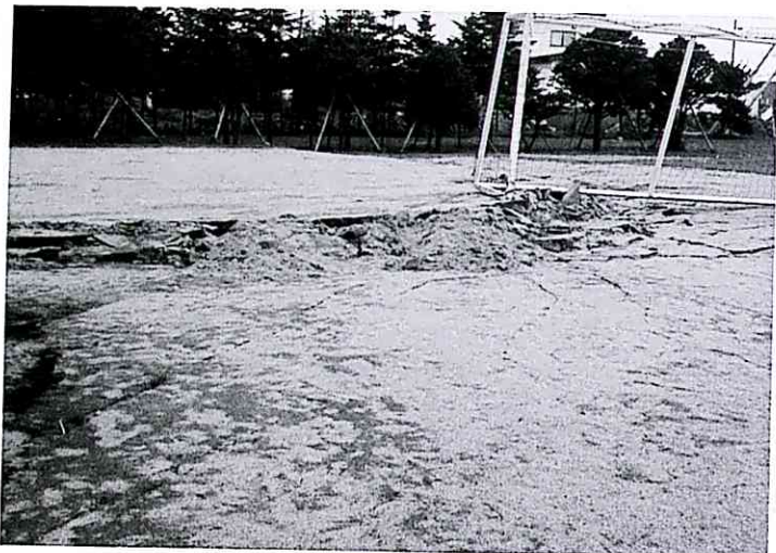
写真-19 噴砂ときれつの段差
