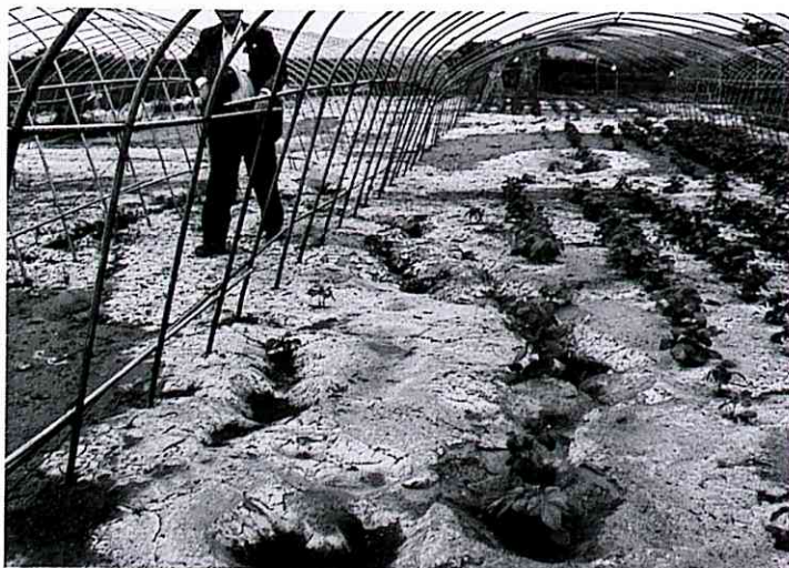
写真-13 今金町豊田、水田のクラックと噴砂、ビニールハウス内の噴砂
