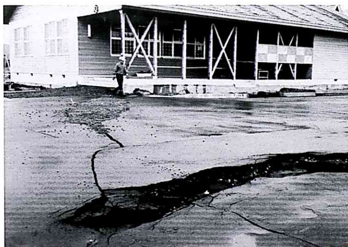
写真-4 前庭のクラックと陥没
