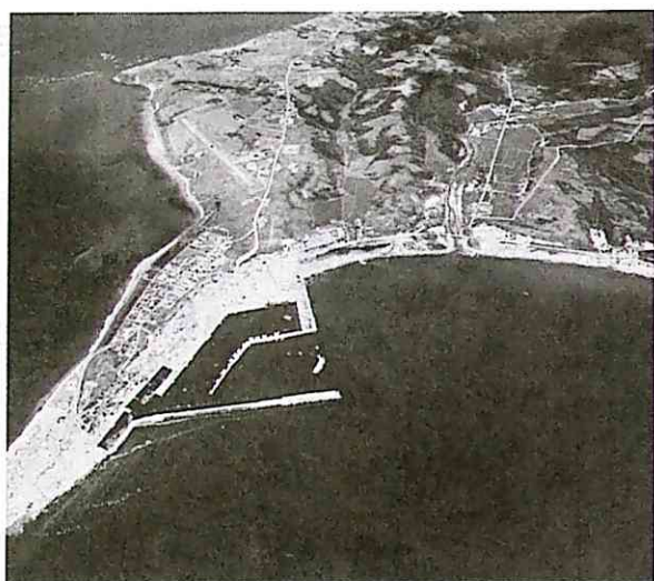
図-14-1 奥尻島青苗地区の津波被害（アジア航測機による）
