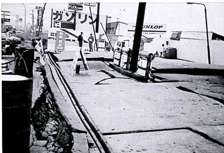
写真-3 ガソリンスタンドの変形 (同上)
