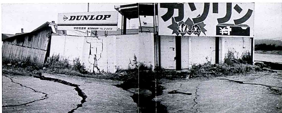
写真-1 ガソリンスタンド周辺の開口きれつ (北海道開発コンサルタントによる)
