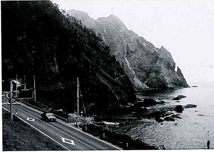
写真-1 岩内町雷電岬、刀掛トンネル崩壊地を望む
