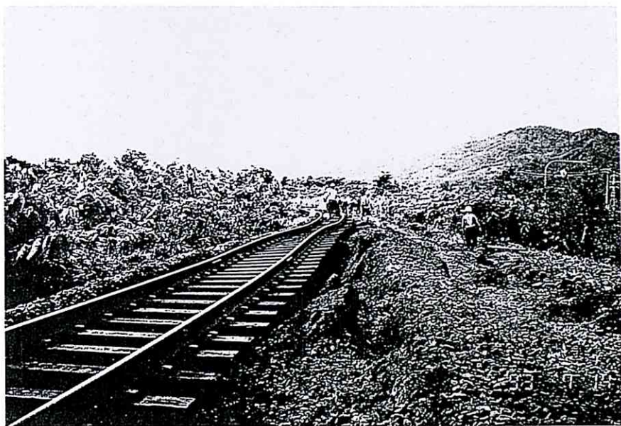
写真-6 鉄道盛土の崩壊と線路の変状（長万部町蕨岱付近）
