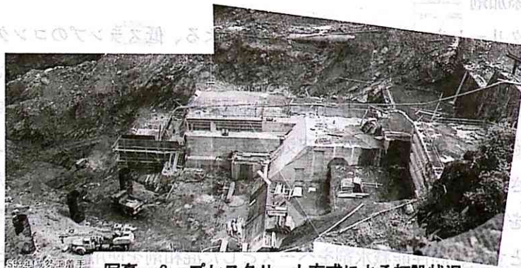
写真-6 プレスクリート方式による打設状況
