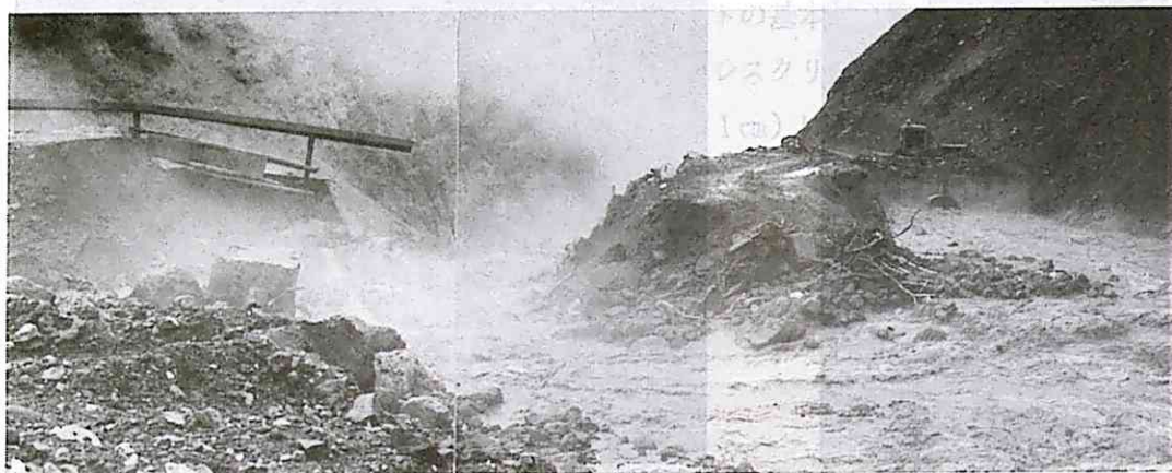
写真-11 二次土石流による仮排水路閉塞、越流
