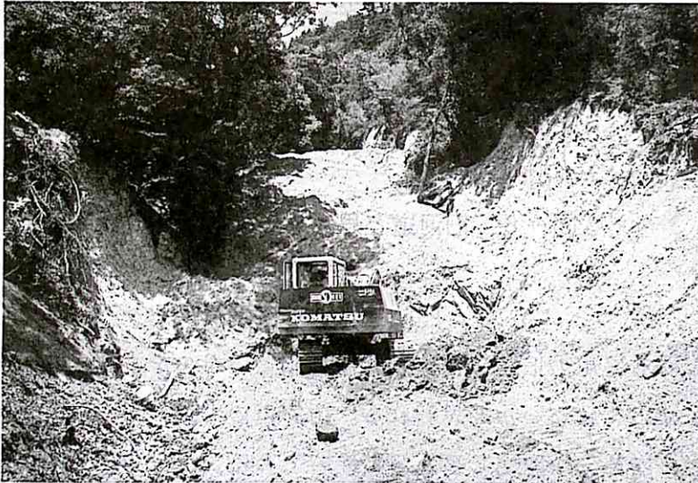
写真-7 溪流へ砂防ダムを建設中
