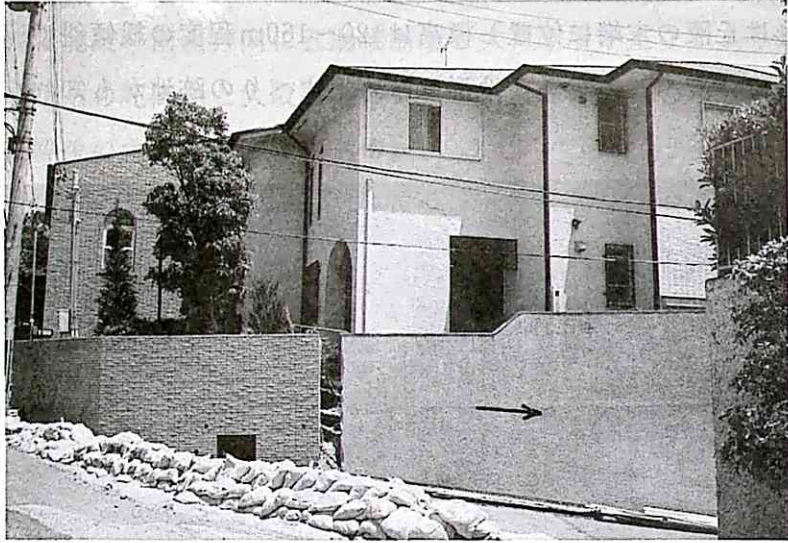
写真-9 台地南側の壁面の分離
