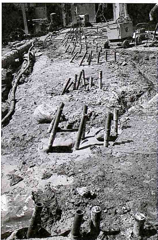
写真-11 六甲大橋本土側橋脚部のグラウト工事
