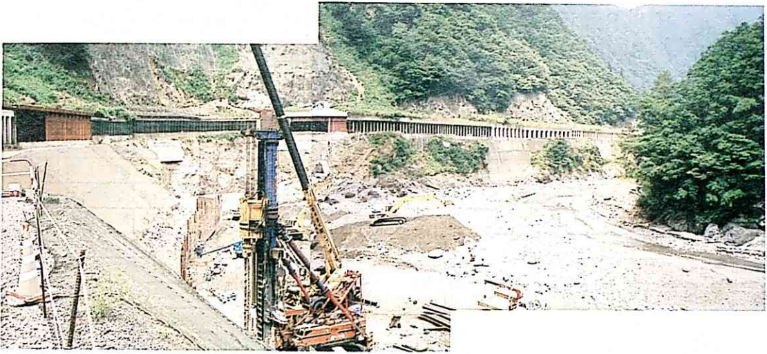
写真-3 突付洞門付近の復旧状況
