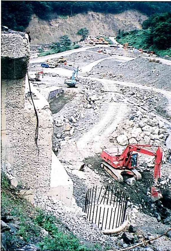
写真-4 R148 新国界橋跡
