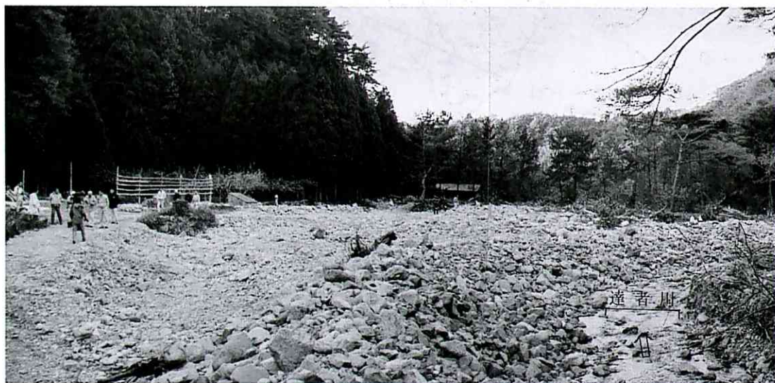
写真-2 達者川の土石流跡（河口より500m付近、上流側より下流方を望む、石川幹事撮影）
