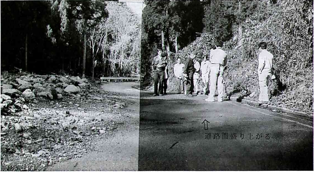
写真-4 久知川土石流跡 (道路に盛り上がりがあり、その要因を議論?中)
