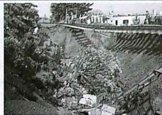
線路の地盤が流された越後線
