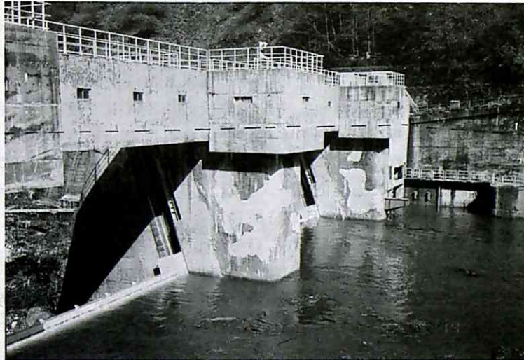
写真3 富山県黒部峡谷仙人谷ダム（黒部川）
