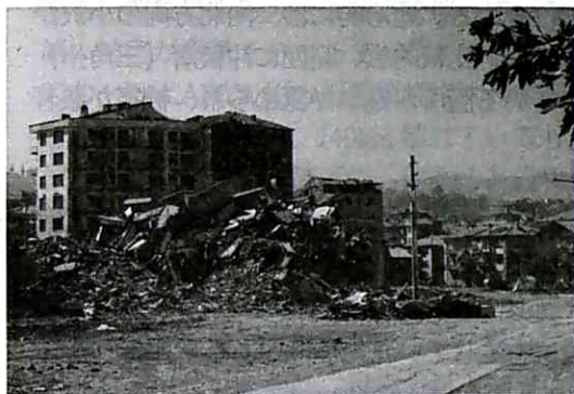
写真-2 GOLCUK 西側地域/地表断層直上のビル倒壊状況
