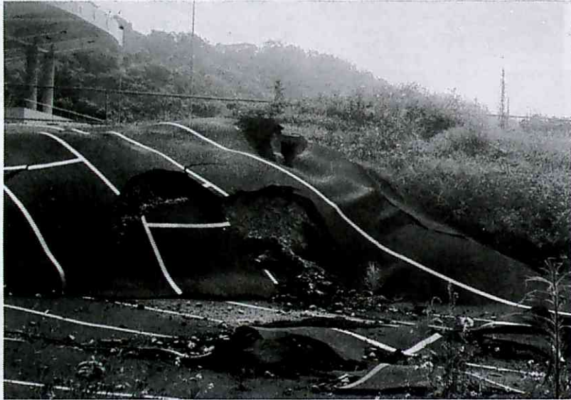
写真.4 霧峰運動公園のトラックに生じた地震断層
