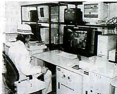
写真-1 無人化施工状況①
