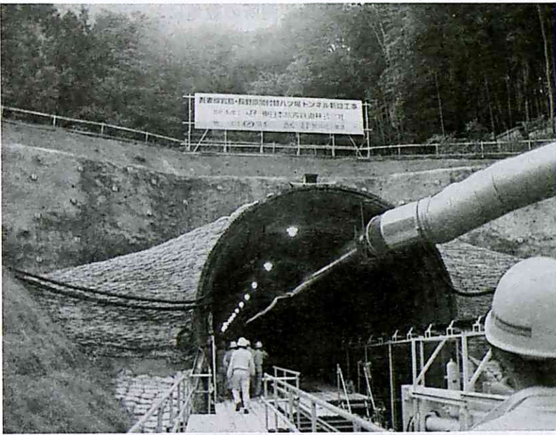
写真-1 ハツ場トンネル入り口付近
