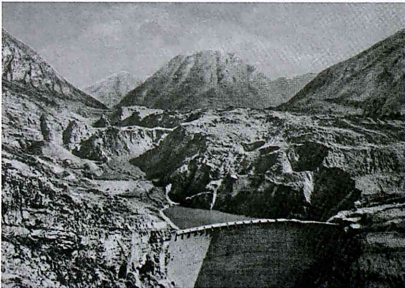
写真4 岩盤すべり発生後の状況（絵葉書）。
