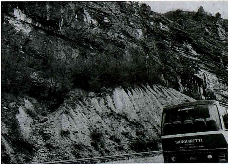
写真9 ダム上流右岸側。左岸側からすべり出した土砂が右岸まで達している。
