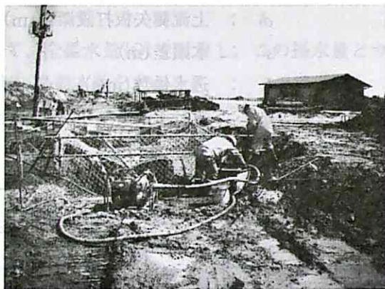
②掘削状況
