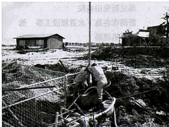
⑥ストレーナー等挿入状況
