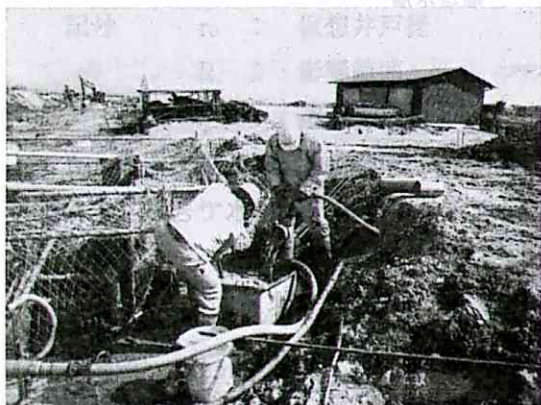
③掘削状況
