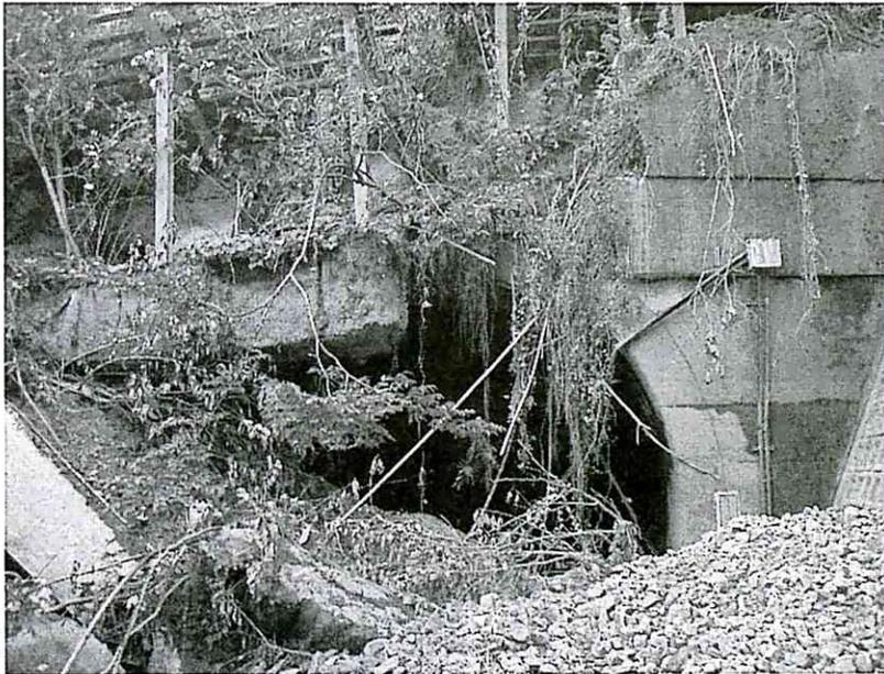
写真－4 被災直後の羽黒トンネルの状況
