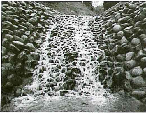
写真2 No.5~8 谷止工は、前面を粗石付の スロープにした。
