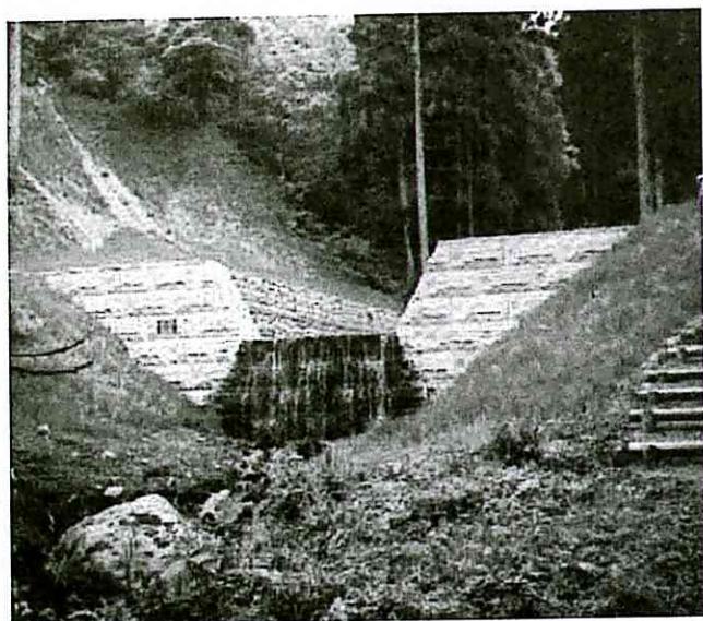
写真6 No.8谷止工。 谷止工付近の土の斜面を利用してカエルが迂回していた。
