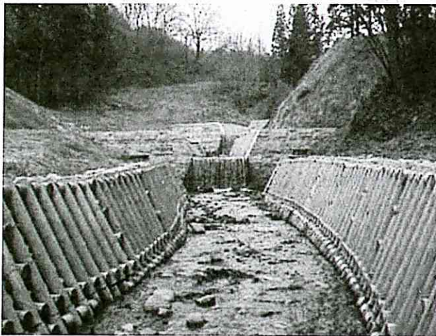
写真4 間伐材による法枠工護岸の流路工区間。 当初計画では、垂直の谷止工の間に隙間なくこの 護岸が施されることになっていた。
