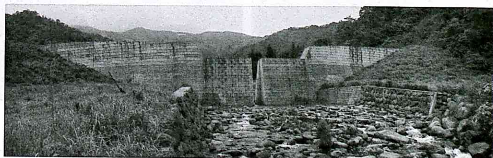
写真3-2 コンクリート製スリットダムの施工例（御備川第3号砂防堰堤）
