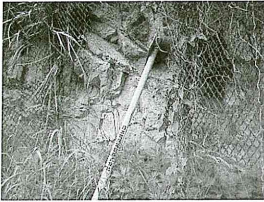
写真2 金網の連続破網状態
