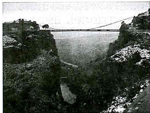
写真.1 コンスタンチン吊橋
