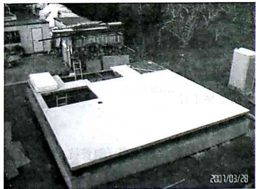
地下躯体完成
