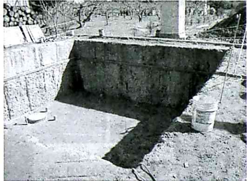
掘削状況（土間部分は、表層地盤改良）
