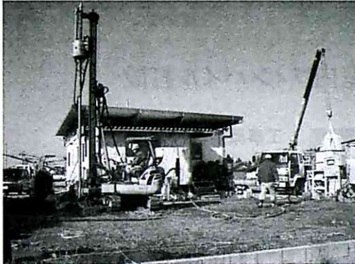
躯体外周部に柱状改良による連続壁
