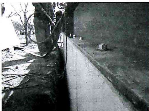
裏込めコンクリート打設
