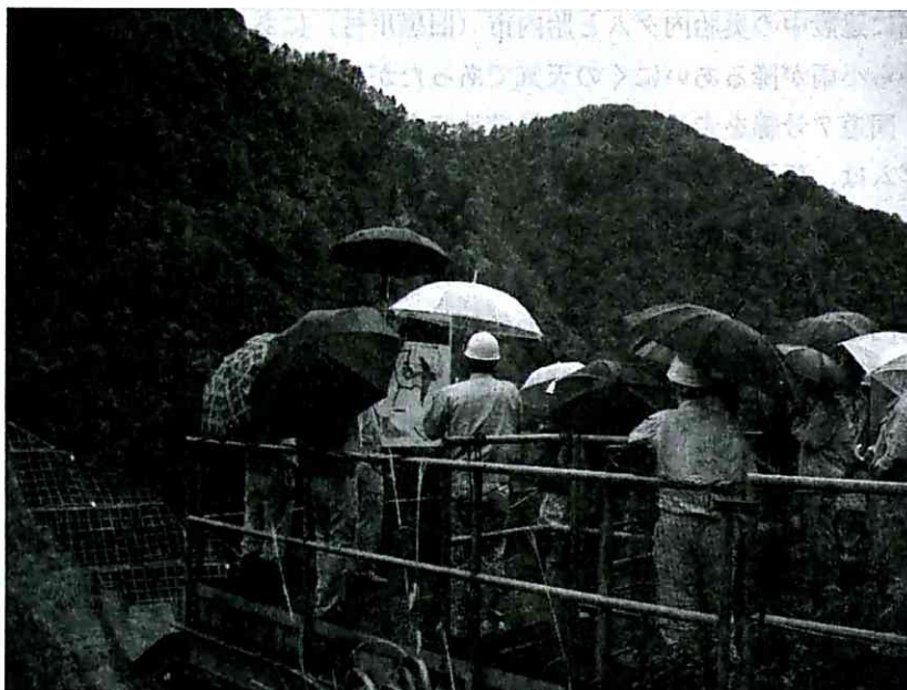
紅葉し始めた山に囲まれながら、工事現場にて説明を受ける
