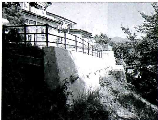
写真5 竣工 (D工区)
