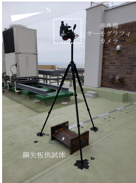
図 6-21 赤外線計測の状況
