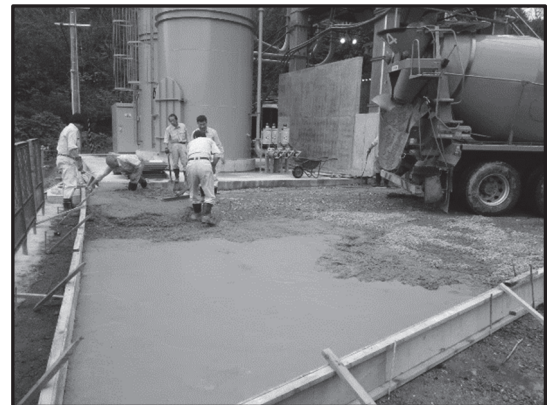
図-A2.4.2 施工状況
