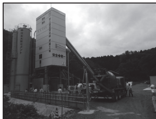
図-A2.2.2 構造物の外観
