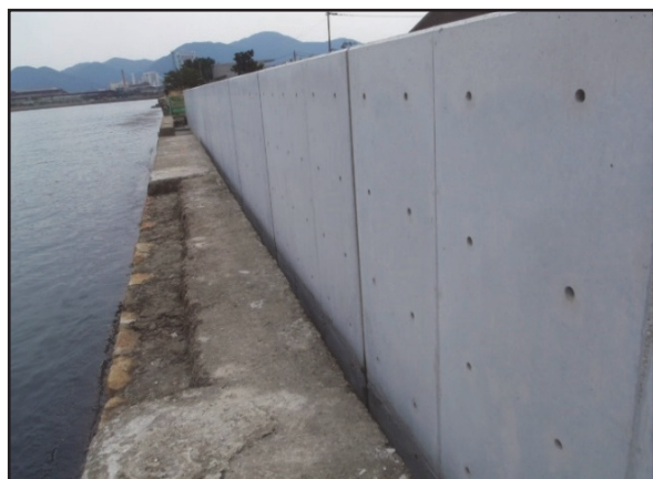
図-3.2.2 構造物①の外観
