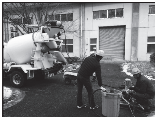
図-7.2.2 シリカフェュームスラリー投入状況
