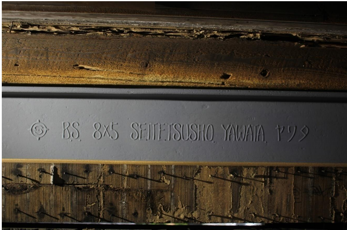
図 (33) 日本製鉄株式会社八幡製鉄所製鉄骨 (筆者撮影)
