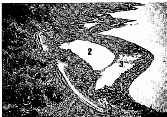
写真-8 旧道(1)を迂回させることによって作られた雪崩防止池(2)（新道(3)がまだ工事中の写真）
