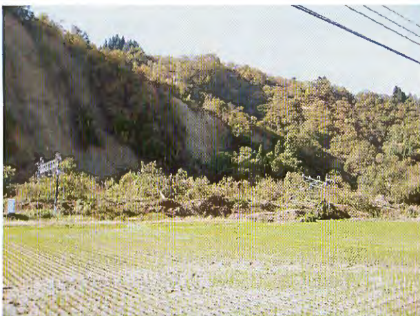
写真-1 JR上越線、北堀之内駅西方の斜面表層崩壊。JR上越線の路盤を覆う。
