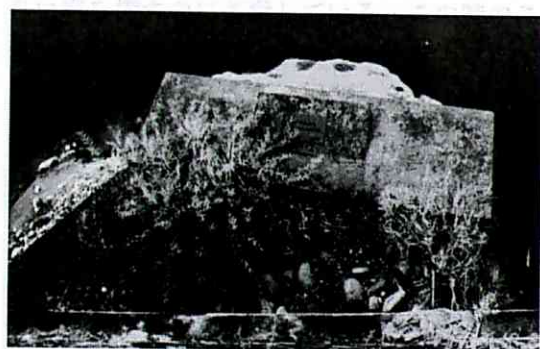
写真-2 旧きりん橋の橋台
