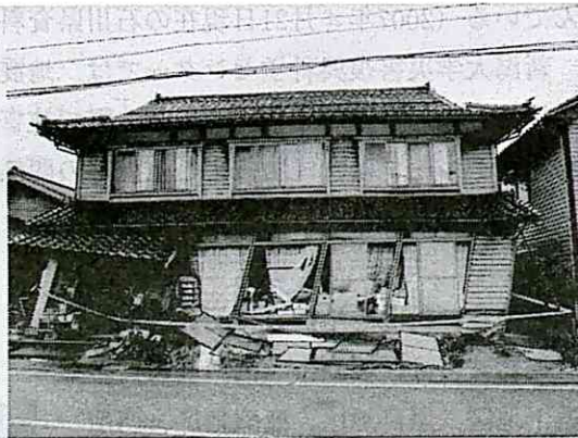
写真2 木造住家の全壊(旧門前町道下地区) 基礎は礎石建ちタイプであった。
