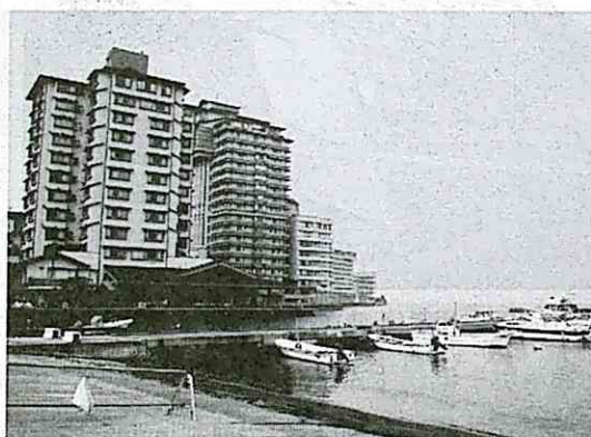
写真8 海岸沿いに立地する和倉温泉のホテル埋め立て部分の護岸や敷地内で変形が生じた
