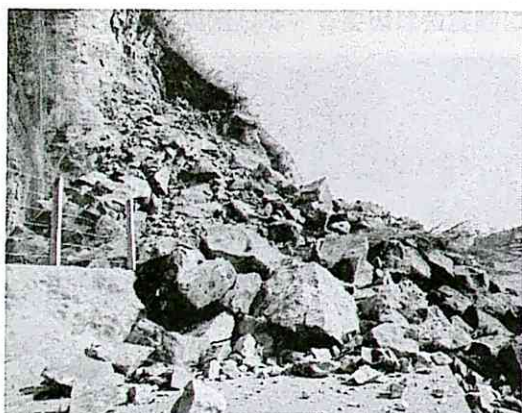
写真9 海岸沿いのがけ崩れ(輪島市輪島崎)
