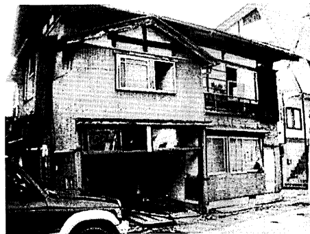
写真 2 全壊木造家屋(川口町震度計周辺)
