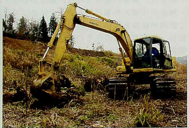
写真13 抜根作業 (03.11.27)
