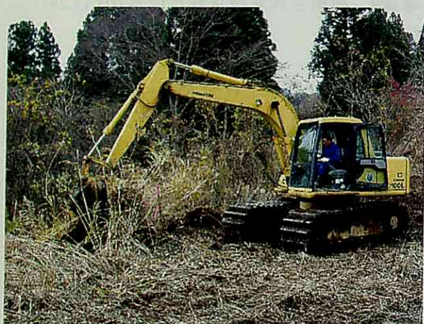
写真10 カヤの除根作業 (03.11.27)
