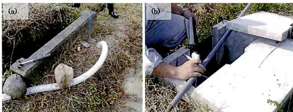
図3-1 連結暗渠区における自然圧による地下灌漑
