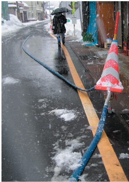
図 14 川口町で消雪用に設置されたサニーホース
