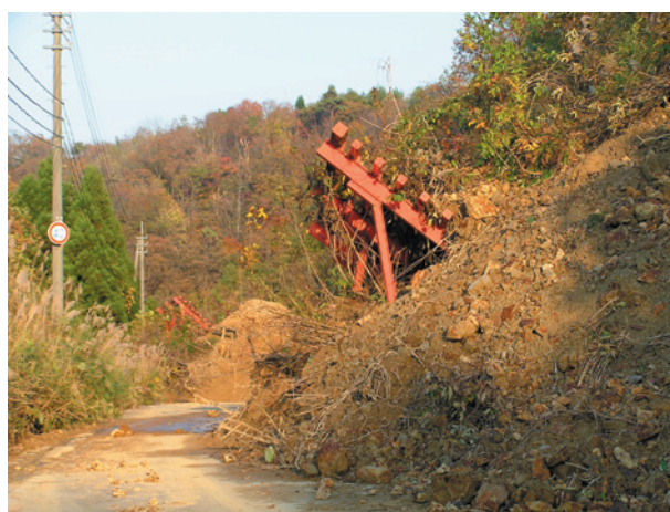
図1 基礎ごと崩落した雪崩予防柵（小千谷市）
