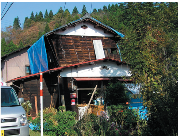
図4 ブルーシートで屋根を覆った地震被害家屋（川口町）
