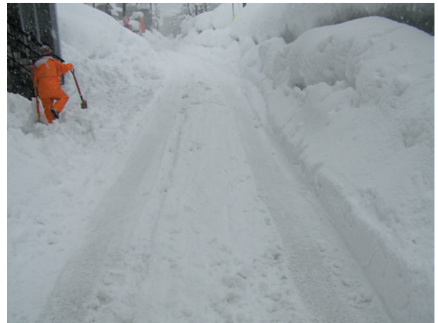
図 15 サニーホースによる消雪が機能しなかった時の路面状況（川口町，1月13日）
