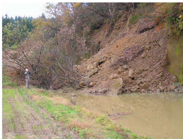
図2 溪岸崩壊による河道閉塞（川口町）
