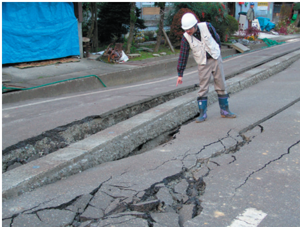
図3 消雪パイプの破損（小千谷市）
