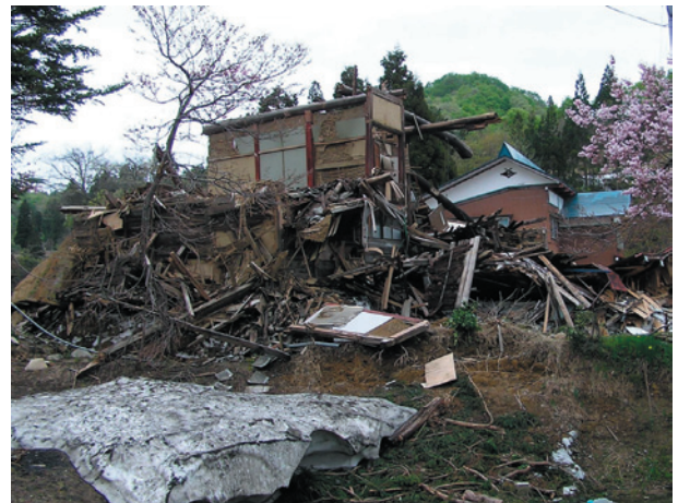
図 16 地震で被災した後に雪によって倒壊した家屋（魚沼市）
