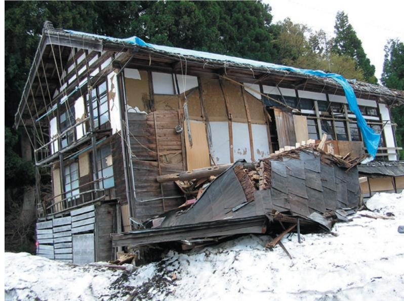
雪によって軒先が破壊した被災家屋
