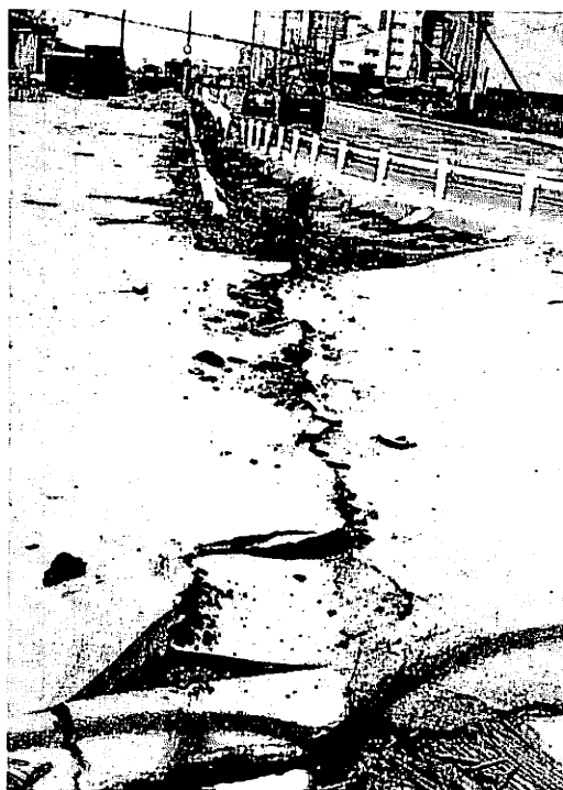
写真－9 アスファルトが盛上がった衝上性亀裂
