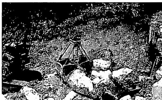
写真-28 Kaltenbrunner Bachの近自然 砂防工事状況（巨礫を用いた工事状況）
