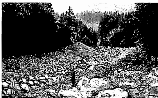
写真-25 Kaltenbrunner Bachの近自然 砂防工事状況（巨礫を用いた床固工）
