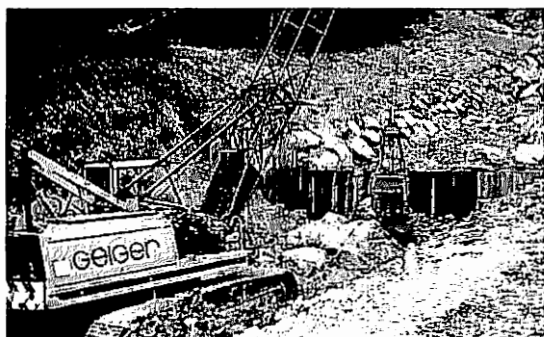
写真-27 Kaltenbrunner Bachの近自然 砂防工事状況（巨礫を用いた工事状況）
