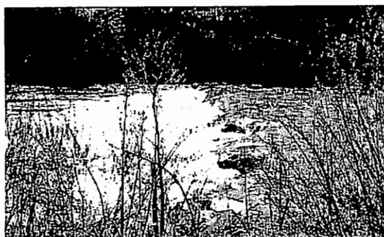
写真-22 Iller川の近自然河川改修状況 (巨礫を用いた落差)
