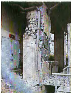
写真四 上越新幹線と南津第3高架橋の損傷。2本ラーメン形式の橋脚がせん断破壊による損傷を受け座屈している。
