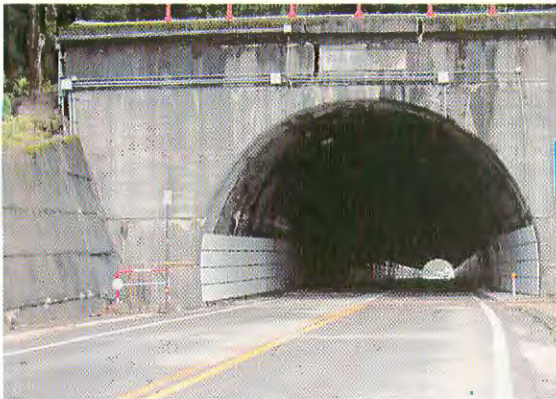
写真一 国道17号線と南津トンネルの損傷。坑口のコンクリートの破損状況から上からの衝撃損が認められる。トンネル内では、上部覆工コンクリートの陥落が生じた。
