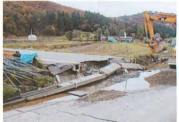
写真六 道路や用水路の寸断。写真左手(東側)の緩斜面が西方向へはらみだしている(和南津地区上河原)。
