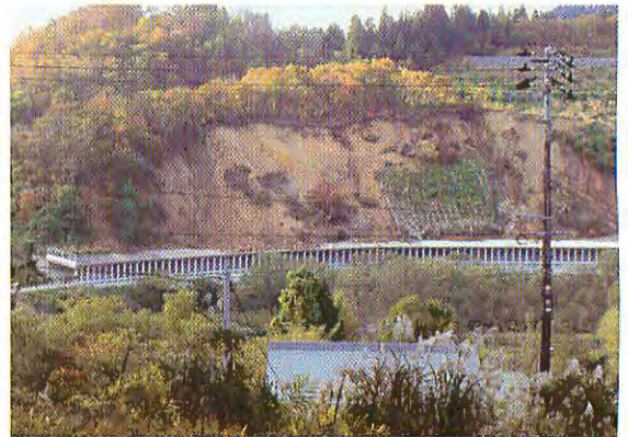
写真五 魚野川右岸(和南津トンネルの対岸)沿いの県道に設置されたスノーシェッド上部の法面崩落。コンクリート製の法枠もろとも崩落している。
