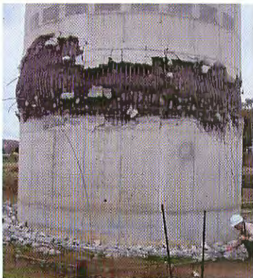
写真三 写真一七における左側橋脚の損傷状況。主筋が座屈している。
