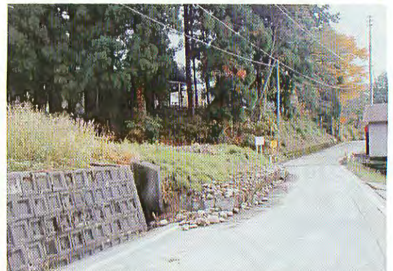
写真七 西方向(右側)への法面のはらみ出し(和南津地区上河原)。
