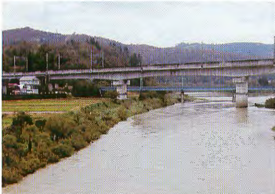
写真二 魚野川に架けられた上越新幹線と南津第3高架橋の損傷。氾濫原面に施工された2基の橋脚がせん断破壊による損傷を受けている。
