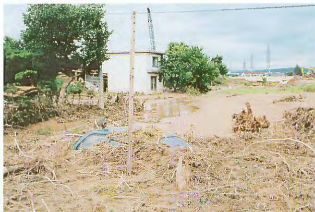
写真一③ ボイリング痕(7/19撮影). 車輛が完全に埋積している. 写真後方の白い部分が仮堤防. 図一4の③
