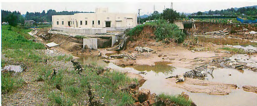
写真一⑨ 上北谷地区浄化センター北西側における堤内堤防の破堤(7/27撮影). 写真前方の崩れかかった刈谷田川堤防部と浄化センター脇の盛土部分を結ぶように、堤内堤防が存在した. 図一7の⑨.
