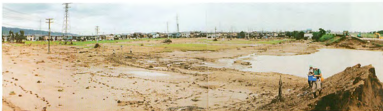
写真一① 五十嵐川上流側からみた破堤と土砂の流出状況(7/19撮影). 破堤箇所には洗掘によって池が形成された. 図一4の①.
