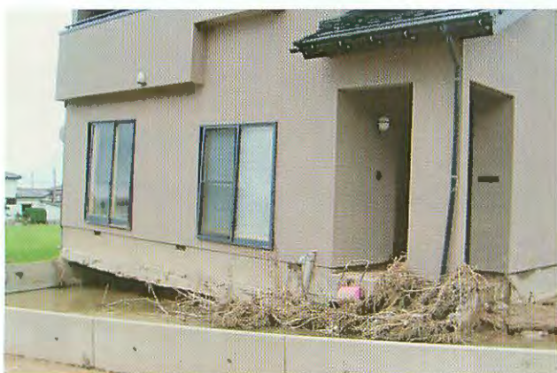
写真一⑥ 基礎が移動して大きく傾いた家屋(7/19撮影). 図一4の⑥.
