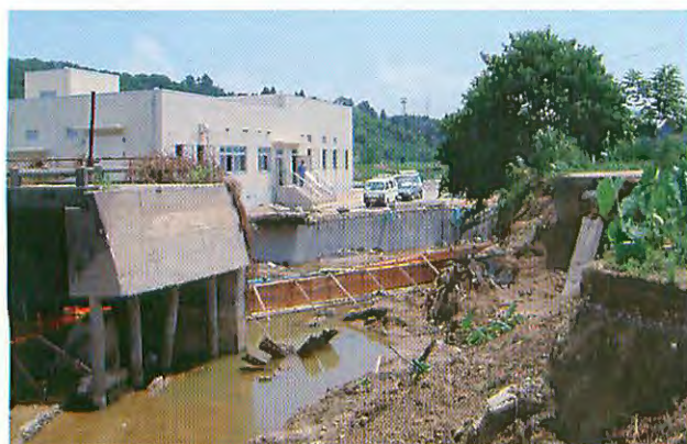
写真一⑩ 上北谷地区浄化センター南西側の破堤(7/27撮影). 段丘V面上に位置する畑地(写真右)が一部流出した. 図一7の⑩.
