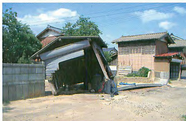
写真一⑪ 倒れたブロック塀に覆いかぶさる車庫(7/22撮影). 図一7の⑪.
