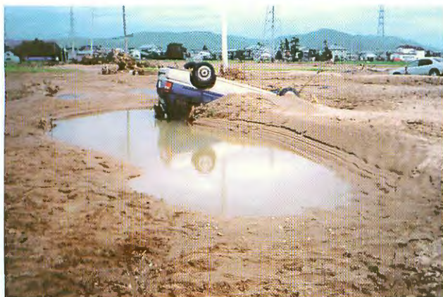
写真一② ボイリング痕(7/19撮影). 図一4の②
