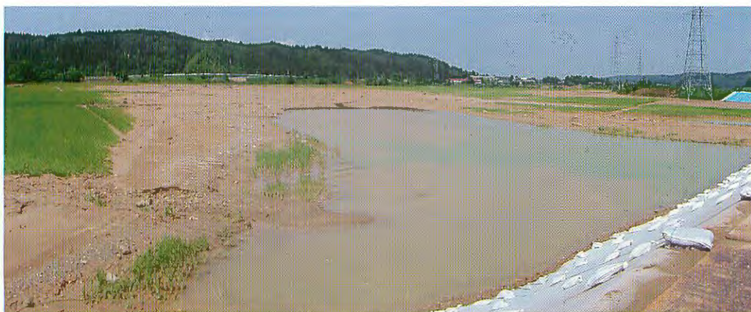
写真一⑧ 稚児清水川左岸の破堤によって水田に流出した土砂(7/26撮影). 仮堤防の法尻部には、洗掘によって池が形成された. 図一7の⑧
