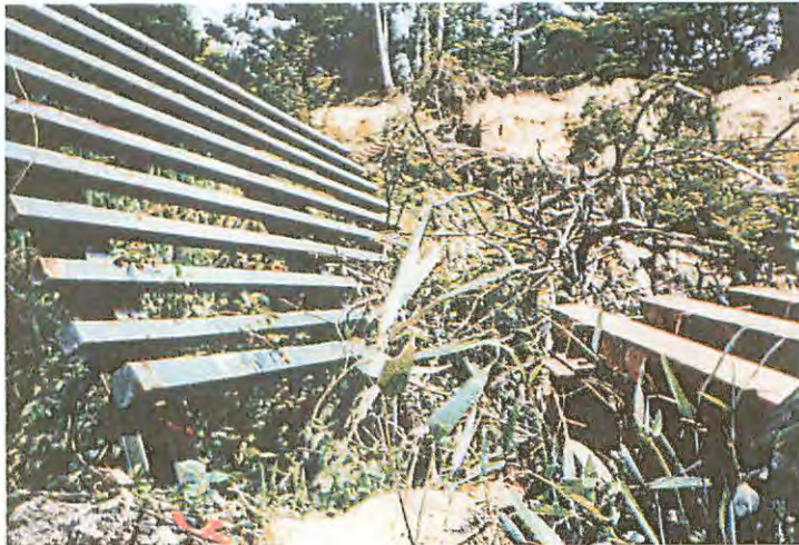
写真-1, 2 小千谷市川井で倒壊した予防柵(図-2中の凡例; 移動量大の予防柵)
