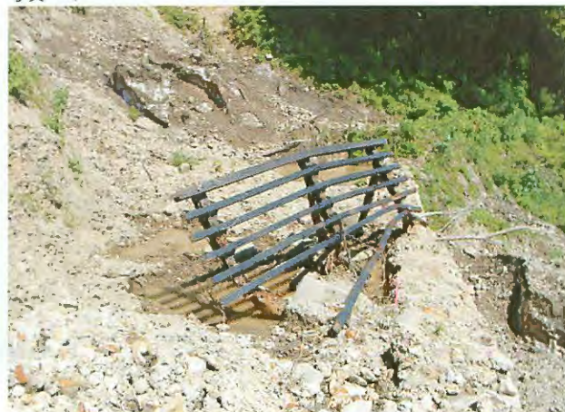
写真一 4 破損・転落した予防柵(長岡濁沢)
