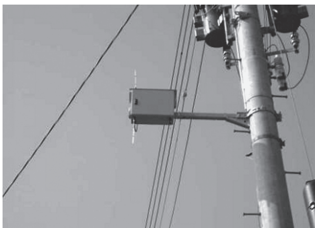
写真－３ 電柱上に設置された通信ノード
